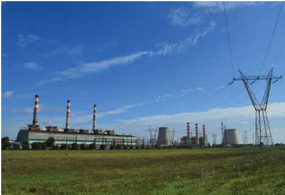
CENTRAIS TERMOELÉTRICAS A Central Termoelectrica do Ribatejo, desactivada em 2010 e em fase de desmantelamento, utilizava fuelóleo e gás natural na produção de energia eléctrica. A Central do Carregado entrou em funcionamento faseadamente, em 2004 e 2005, a partir de gás natural. THERMO-ELECTRIC PLANTS The Ribatejo Thermo-electric plant, deactivated in 2010 and currently being dismantled, used fossil fuels and natural gas for the production of electrical energy. The Carregado plant began its activity in phases, over 2004 and 2005, using natural gas.
