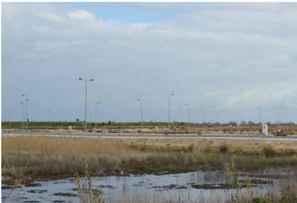
PARQUE LOGÍSTICO LISBOA NORTE No arranque do PLLN do Carregado, em 2008, foi reconhecido o interesse público nacional. Em 2011, o travão do financiamento privado para a construção da plataforma de 100ha deixou-a apenas com os acessos e infraestruturas construídos. NORTH LISBON LOGISTICS PARK The kick-off of the Carregado NLLP in 2008 was met with national public interest. In 2011, the halting of private funding for the construction of the 100 ha area resulted in the construction of only its access points and infrastructures.
