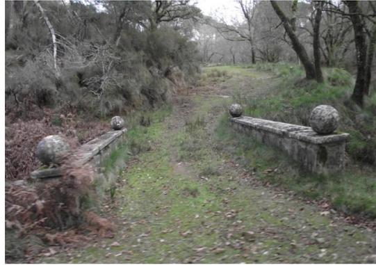
Figura: 93 Duas fotografias que demonstram as pontes e o seu estado de degradação (foto campo).
